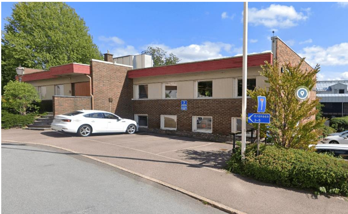
Figur 14: Befintlig byggnad från 1970-talet. Bild från google maps.
