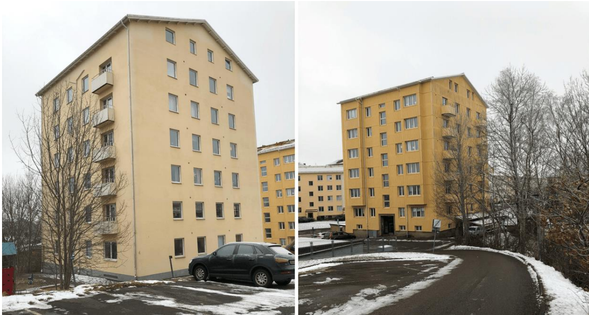
Figur 15: Exempel på funktionalistiska punkthus med inslag av nyrealism vid Wahlbergsgatan. Byggnaden på bilden till höger har tilläggsisolerats och förändrat fasadmateriel vilket gör att dess funktionalistiska karaktär delvis har förvanskats.
